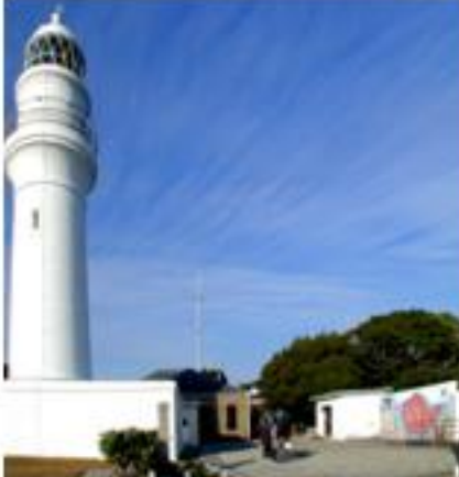
遊覧灯台(和歌山県) 一年を通して一般公開を行っている灯台周辺の壁面は、地蔵の子供たちによって描かれたものです。
