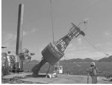
灯浮標の設置
