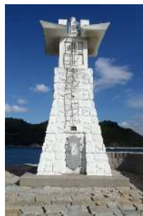
Mitarai Port breakwater LH (Mitarai, Hiroshima)
