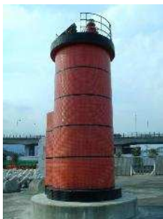
Odawara breakwater LH No.1 (Odawara, Kanagawa)
