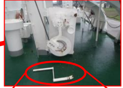
業務用機器の腐食等
