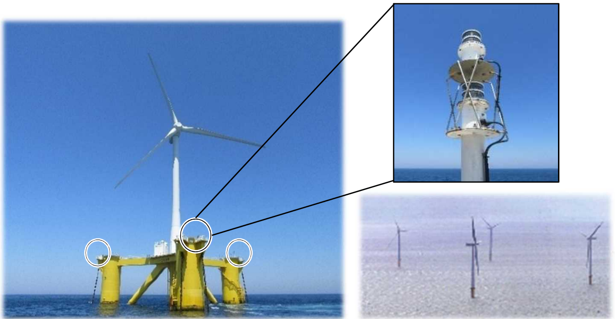
〔風力発電施設〕
