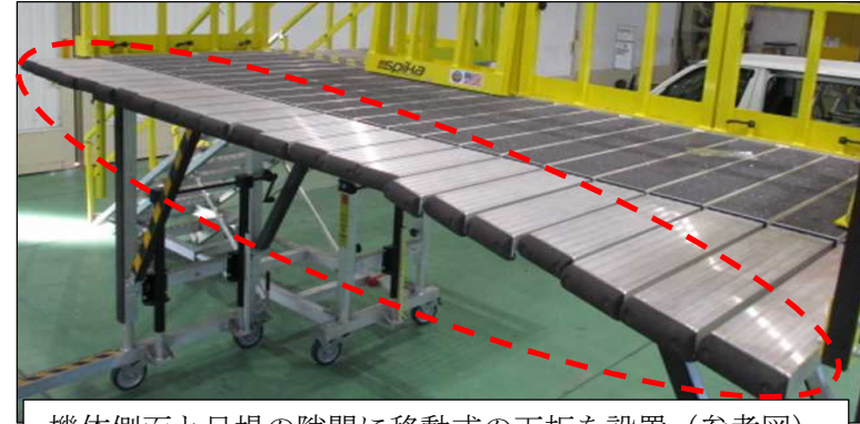
機体側面と足場の隙間に移動式の天板を設置（参考図）
