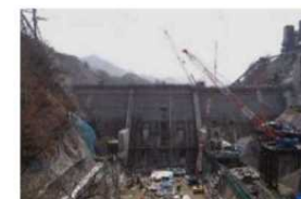
日々変化する工事現場
