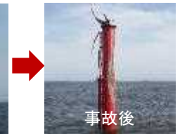
走錨船舶の接触による損傷（灯標の上部脱落） ※過去5年間における船舶接触による航路標識の被害件数 計262件
