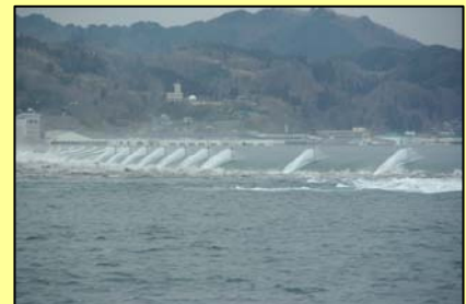
宮古港防波堤を越える津波
