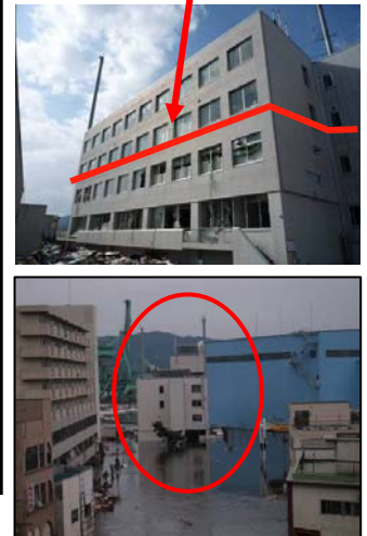
水に浸かった庁舎
