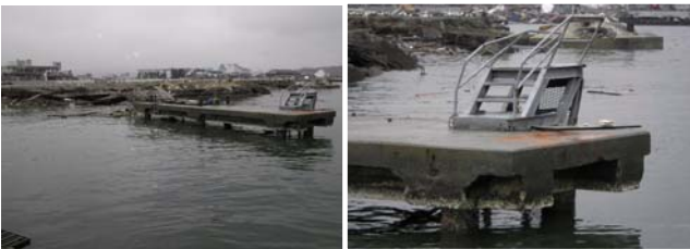
気仙沼海上保安署 船艇基地の被害状況
