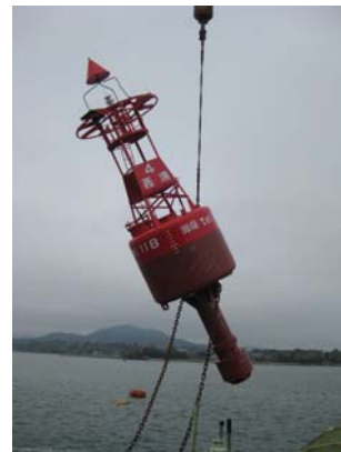
設置作業中（気仙沼港）
