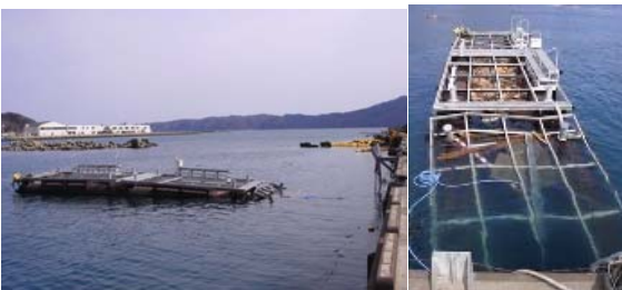
宮古海上保安署 船艇基地の被害状況
