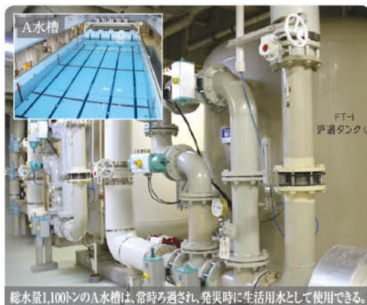
総水量1,100トンのA水槽は、常時ろ過され、発災時に生活用水として使用できる。
