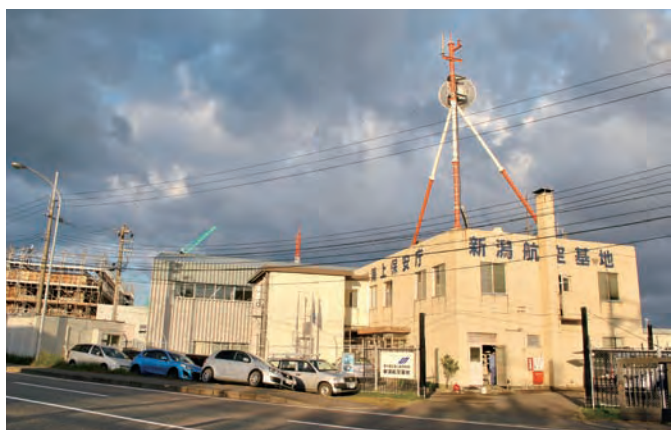
新潟市郊外、新潟空港と隣接する新潟航空基地。現在、第一格納庫裏に新庁舎増築中だ。
