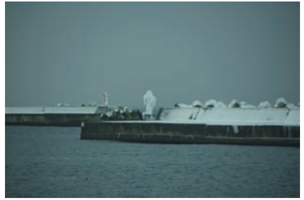
氷をまとった航路標識 (1月17日・小樽海上保安部)
