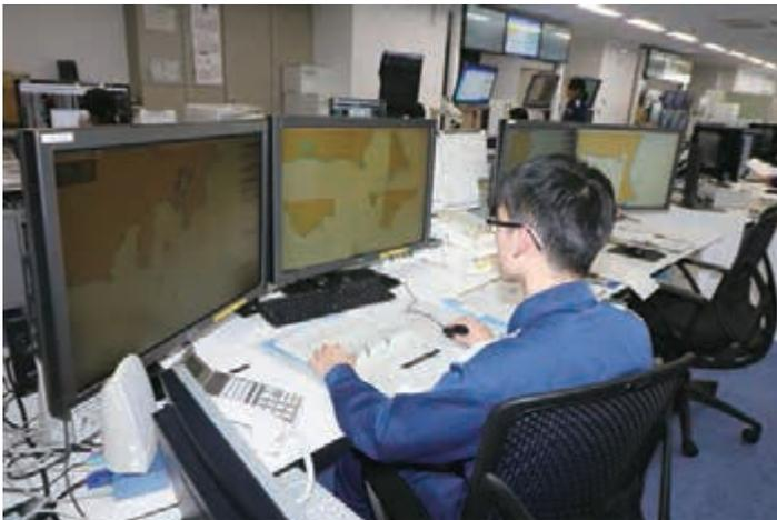
AIS卓では東京湾内を除く第三管区海上保安本部が受け持つ沿岸、茨城県から静岡県までの距岸約20マイルを航行するAIS搭載船を監視し、危険を回避するための情報を提供する。
