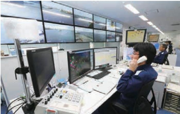
運用管制官の目の前にはモニター画面がズラリと並び、湾内・港内の様子を肉眼で確認することができる。レーダー映像やAISデータを元に船の動きを監視し、必要な管制指示を出す。
