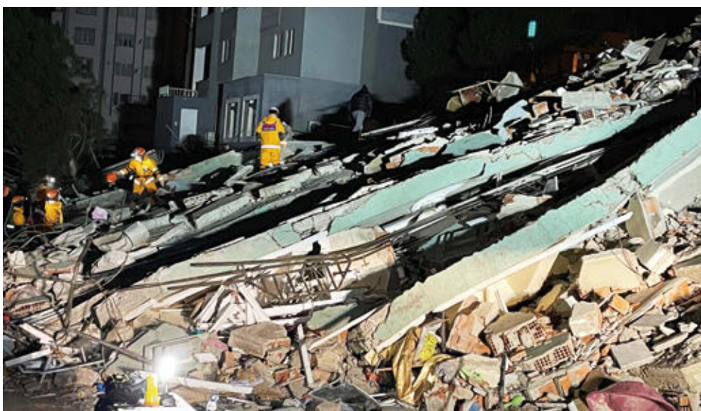
倒壊した9階建てアパート (JICA提供)
