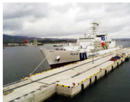
鹿児島A 栈橋
