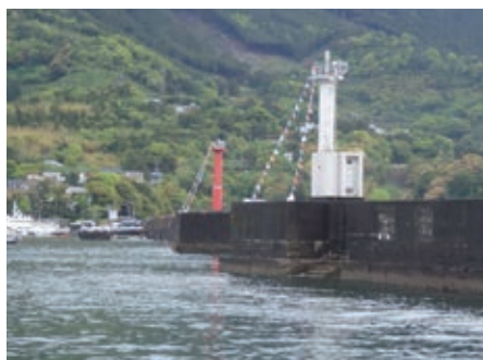
【尾鷲】尾鷲港第一、第二防波堤灯台
