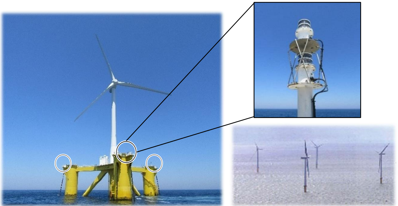
〔風力発電施設〕
