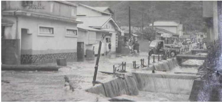
津波で浸水した家屋や道路 (写真提供 名瀬測候所)
