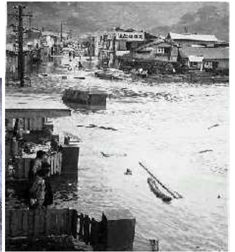
名瀬港湾合同庁舎付近
