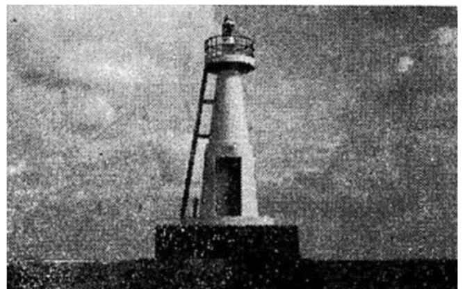
亀徳港南防波堤灯台(燈光から)
