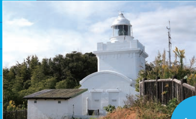
海側よりの灯台全景
