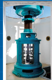
建設当時の回転機械 (灯室)
