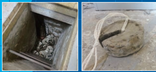
上:1階ホールと分銅室 下左:分銅室内 下右:分銅
