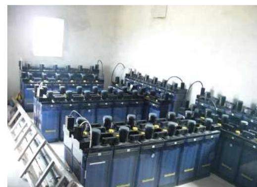
三島灯台は、昼間に太陽電池でバッテリーを充電し、夜間に灯台を点灯させています。灯台の光の強さは、16万カンデラで、約27キロメートル先まで光が届きます。
