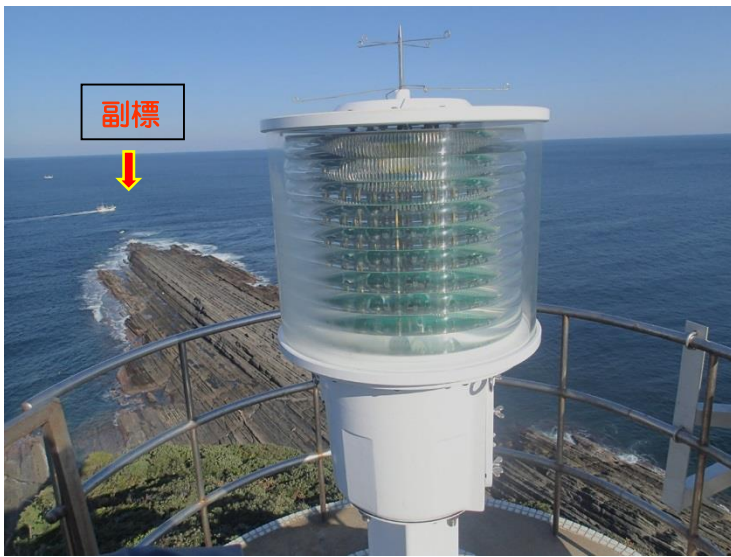
LED灯器 光の強さ：3,700カンデラ 光の届く距離：約22キロメートル
