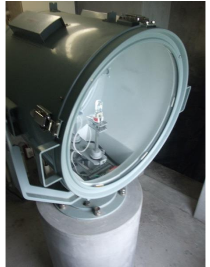
照射灯 光の強さ：1,900,000カンデラ 約320メートル先の副標を照射
