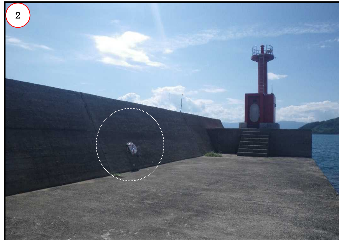
湊浜漁港（岸壁）「漁港奥側」
