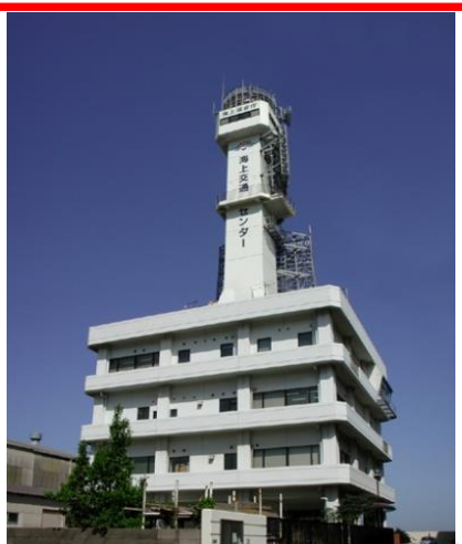
関門海峡海上交通センター 1989年6月 運用開始 福岡県北九州市
