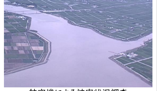
航空機による被害状況調査
