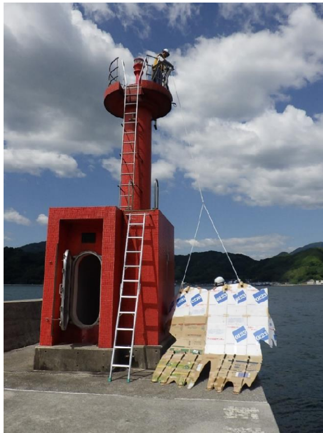
【お面の取付け作業】
