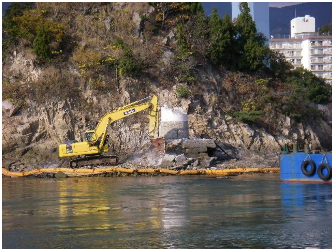
解体撤去中の女猫島灯台
