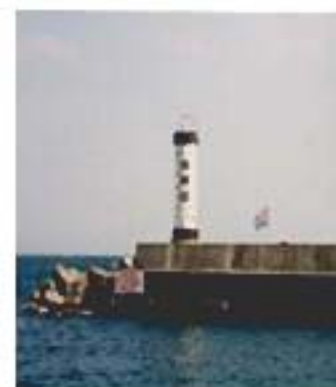
小田原港二号新波堤灯台(神奈川県) 街の特産品である「小田原ちょうちん」をモチーフとし、海を行く船の安全を願っています。
