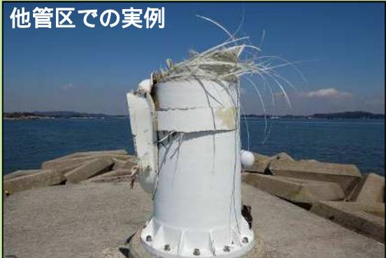
台風による波浪により倒壊が危惧される小規模FRP製の防波堤灯台について補強対策を実施します。
