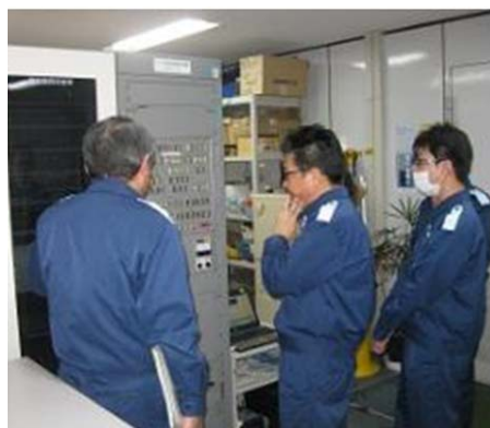
機器の点検状況の確認
