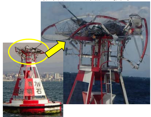
被害状況：灯器全損等
