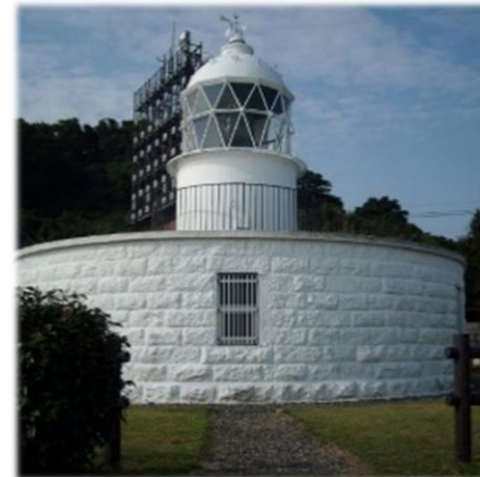
へさき 部埼灯台 (福岡県北九州市)
