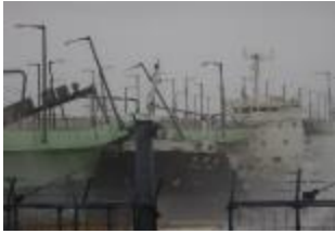
台風時の走錨により閑空連絡橋に衝突したタンカー（H30）
