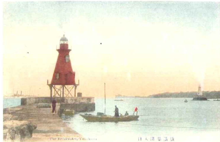
2. 横浜北水堤灯台 明治29年5月16日 ~ 現在
