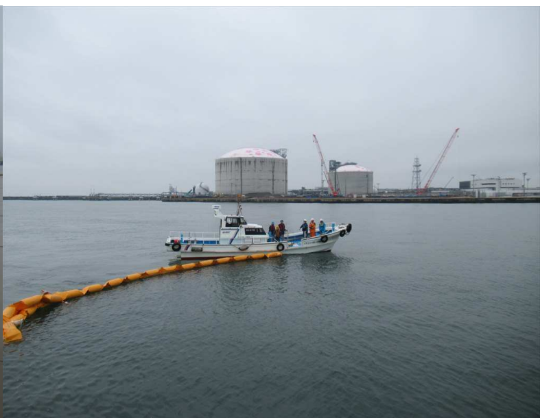
作業船によるオイルフェンス展張作業
