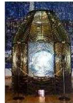
現在のものは灯台局レンズ工場で製作した4面閃光レンズで内径1,840ミリメートル、高さ2,590ミリメートルもある大きなものです。光源には当初は石油灯を使用し、67,500燭光の光度(明るさ)でしたが、大正12年には電化され、現在は市販の400ワットの電球を使用し、実効光度が110万カンデラと、日本では最大の光度を誇る灯台の一つとなっています。
