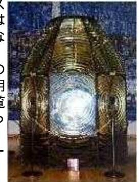
現在のレンズは、旧レンズとほぼ同じ大きさの内径1,840ミリメートル、高さ2,590ミリメートルもある大きなもので、水銀上に浮かべ、モーターで回転させています。灯器も当初は石油灯を使用し、67,500燭光の光度(明るさ)でしたが、明治43年に新式石油灯に改良されて20万燭光となり、大正12年には電化により63万燭光となりました。現在は市販の400ワットの電球を使用し、実効光度が110万カンデラと、日本では最大の光度を誇る灯台の一つとなっています。なお、この電球が断芯したときは予備の電球に自動的に切り換わる装置があり、また、停電に備えて停電補償装置と自家発電設備を持っています。
