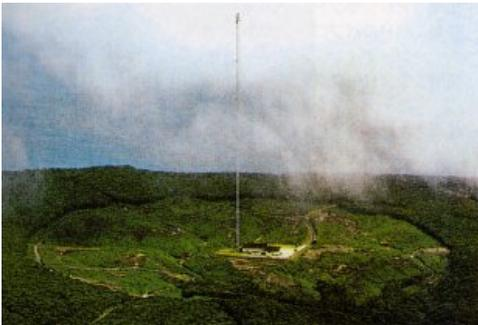
ロラン（LORAN）とは、LONG RANGE NAVIGATION、「長距離電波航法」の頭文字をとったもので、二つ以上の電波の時間のずれを利用して船舶の位置を求めるものです。
