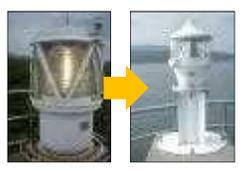
白熱電球を使用していた光源にLED光源を採用。光源の省エネ化により電源の太陽電池化が促進。
