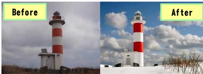
本年5月から10月にかけて、利尻島南側に位置する「仙法志埼灯台」の改修工事が行われました。長年の風や雨・雪に晒されていた灯台は、外壁や内壁のひび割れ、剥がれ、雨漏りが多く生じており、機能を維持するための工事を実施しました。外観の塗装も黒ずんだ状態でしたが、綺麗に化粧を施されピッカピカになりました。でも良く見ると、何かが違う・・・さ～て、どこが変わったのでしょうか???
