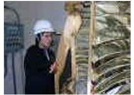
灯台点検・整備
