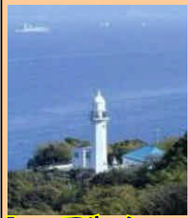
現在の観音崎灯台 (横須賀市)
