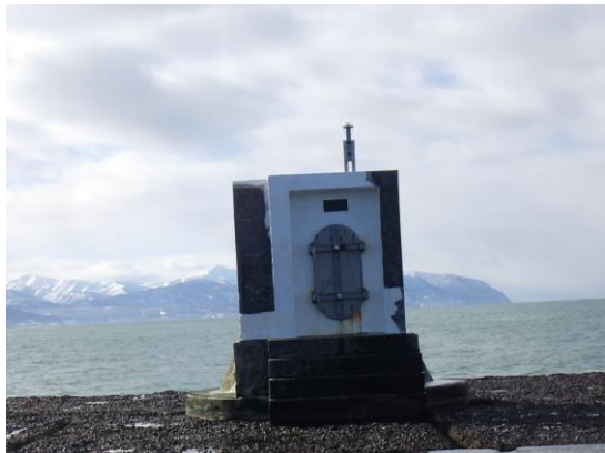
再設置した仮灯
